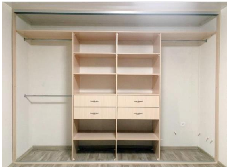
Рис. 1. Пример встроенного шкафа купе, как говорят от стены до стены и от пола до потолка. Для его изготовления понадобится значительно меньшее количество ДСП в сравнении с корпусным шкафом купе, потому что нет крыши, дна и боковых стенок. Такой шкаф купе, конечно, будет стоить дешевле
